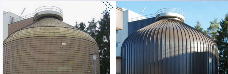
Dämmung verbessert und Fassadenplatten mit Stehfalzplatten ersetzt.
