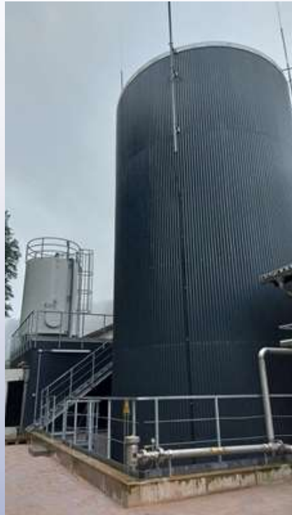
Hochlastfaulturn Standort Kläranlage Felsalbe: Dämmung mit Aluminiumplatten verkleidet.
