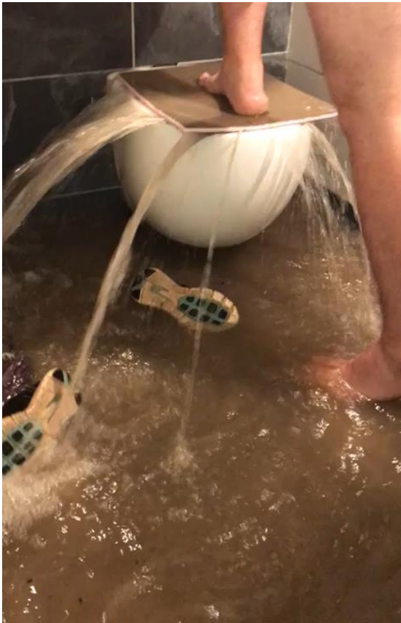
Abbildung 11 Wassereintritt durch fehlende Rückstausicherung in Windsberg 26.06.2022 [Stadt Pirmasens/privat]
