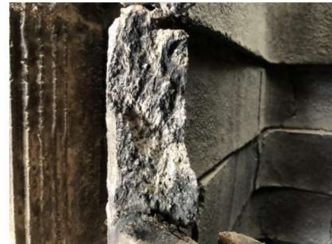
Bild 2: Kamininnenseite, Bruchfläche Schamottsteine
