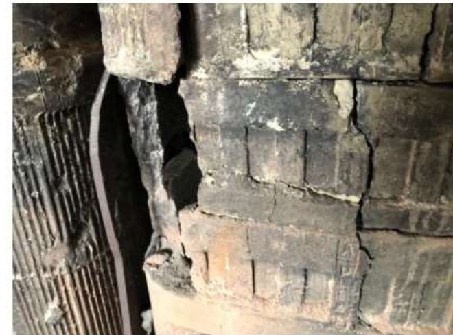
Bild 1: Kaminaußenseite, Schamottsteine
