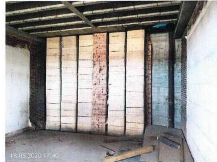
Abbruch Betonschonsteinelemente Pos.2:
