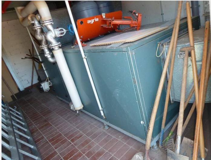
Vorhandene Lüftungsanlage Turnhalle
