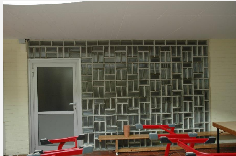
Vorhandene Trennwand Grundschule/ Turnhallenbereich → kein Feuerwiderstand
