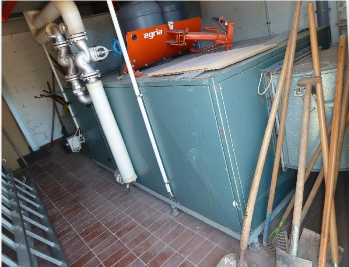
Vorhandene Lüftungsanlage Turnhalle
