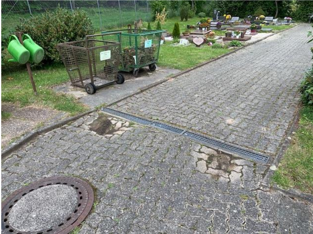
Absenkungen im Bereich Entwässerungsrinne
